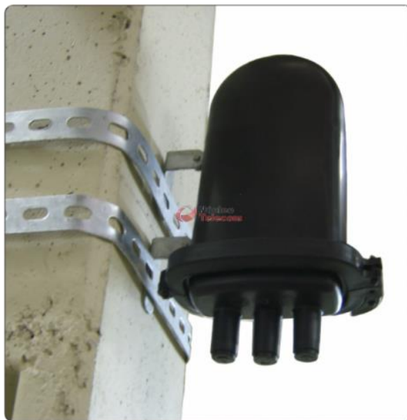
Figura 5.9 – Exemplo da Caixa de Emenda Óptica.
