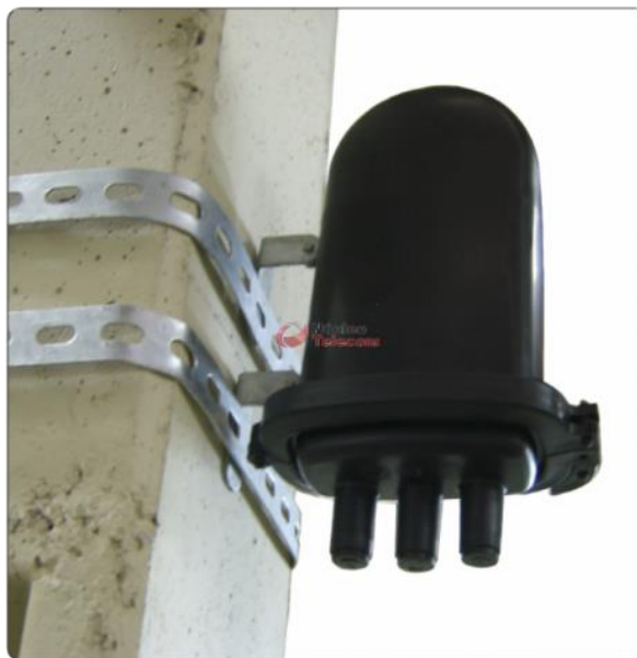
Figura 5.9 – Exemplo da Caixa de Emenda Óptica.
