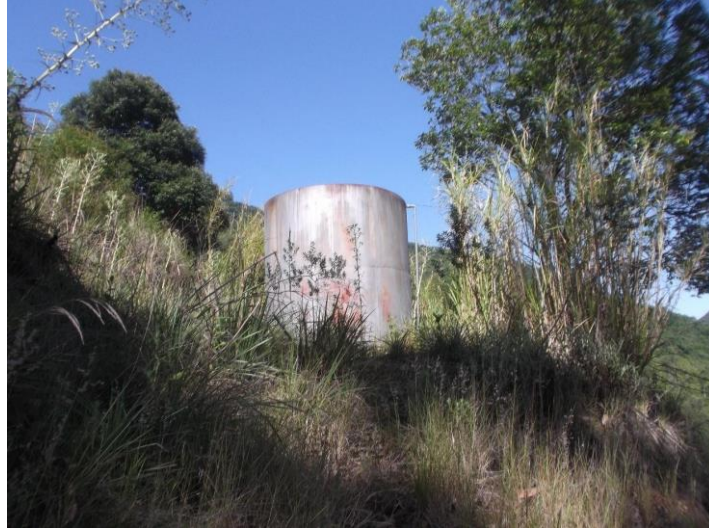
Figura 15: Reservatório de água Linha Alegre Coordenadas Geográficas: 29°119.122'; 051°45.205'
