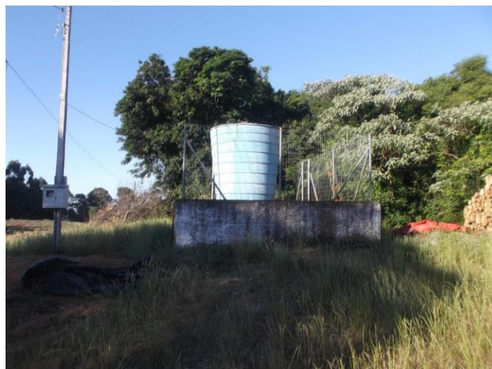
Figura 8: Solução Alternativa Coletiva Linha Nossa Senhora do Carmo São Paulo Ponto de captação Linha Nossa Senhora do Carmo São Paulo Coordenadas Geográficas: 29°16.761'; 051°46.268'
