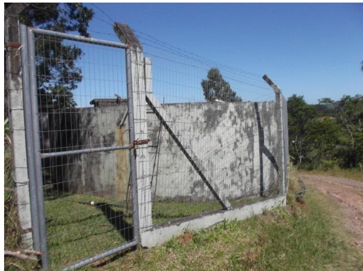
Figura 5: Reservatório de Água Sede Coordenadas Geográficas: 29°16.424'; 051°40.843' Localização: Avenida 25 de Julho, Sede – Coronel Pilar/RS
